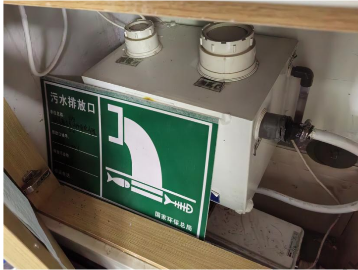
图 4-2 废水处理设备
